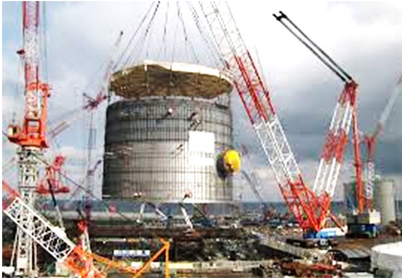
原子力発電プラントの建設 大型ブロック工法、モジュール工法等を大幅に採用
