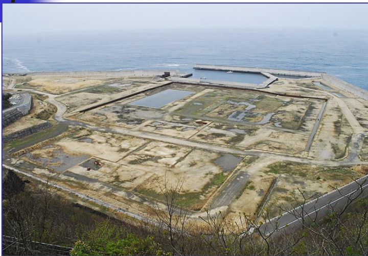
敦賀原発3、4号機の増設予定地
