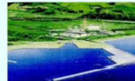
● 電源開発(株) 大間原子力発電所第1号機 (原子炉設備)
