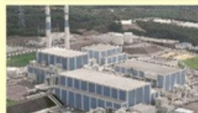
● 北陸電力(株) 志賀原子力発電所第2号機 (2006) (原子炉・タービン設備)
