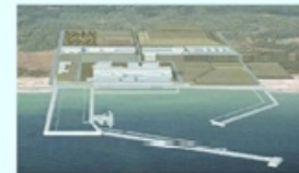
● 東京電力(株) 東通原子力発電所1号機 (共同建設)
