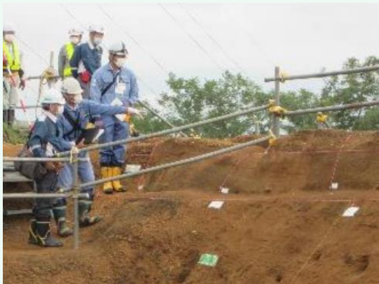
地盤審査（規制委員会による現地調査の様子）
