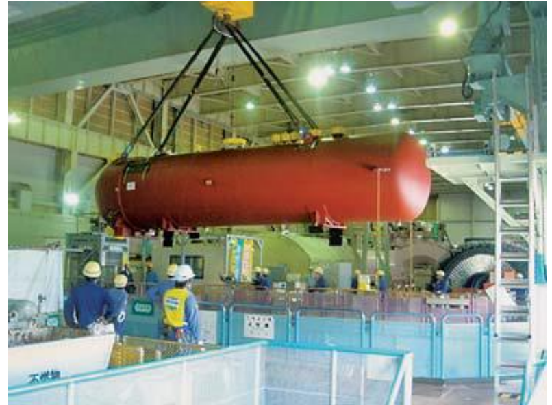
高圧給水加熱器取替
