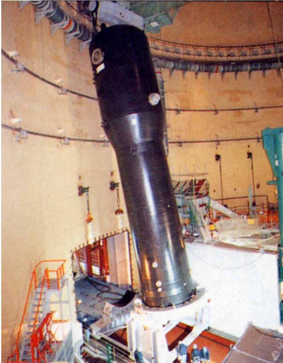
蒸気発生器取替
