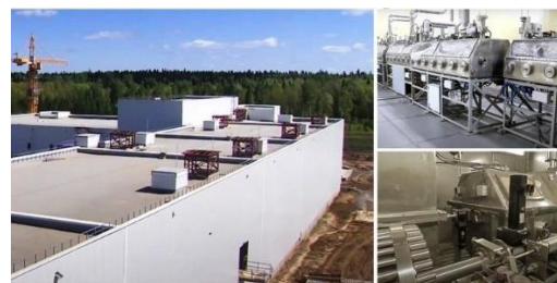
図6 建設が進む PDEC の燃料製造施設
