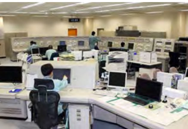
写真 6.6：日本原燃のウラン濃縮工場の中央制御室(日本原燃提供)
