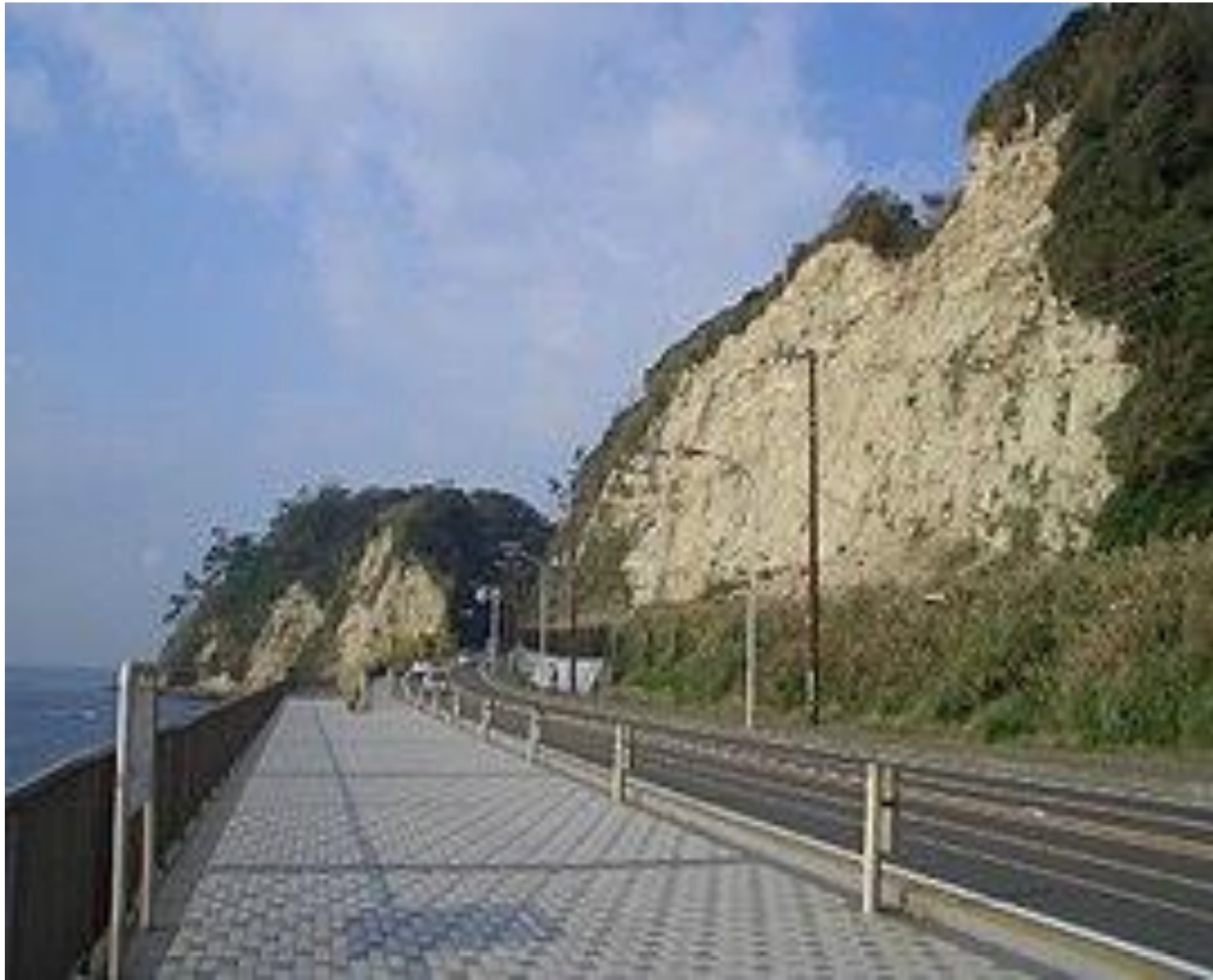
図 24 神奈川県稲村ヶ崎。このような護岸工事によって、かつて崖から供給されていた土砂が無くなった。これに伴って、近隣の砂浜で浸食が起きている。
