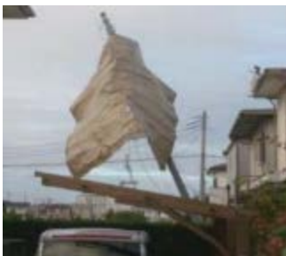
<飛来物による電柱倒壊（東金市）>
