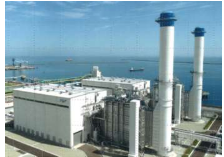
LNGコンバインド火力
