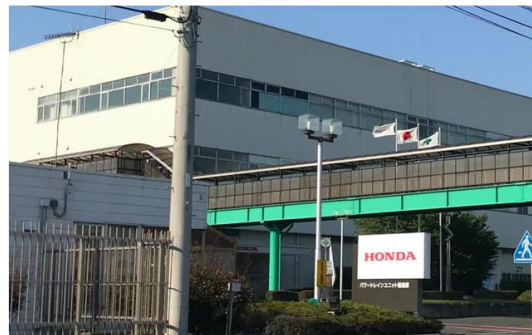
2025年の閉鎖が決まった「パワートレインユニット製造部」(栃木県真岡市)
