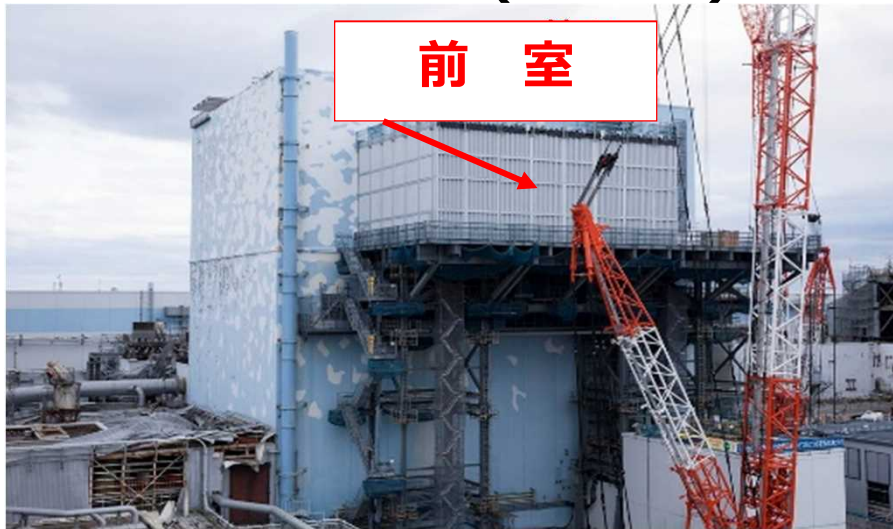
前室の設置 (2017年)
