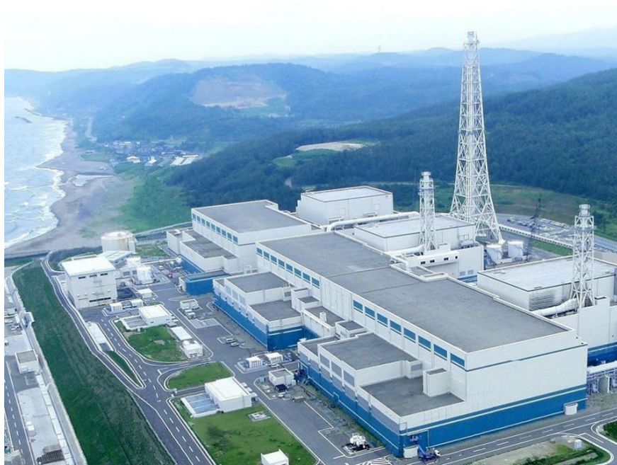
柏崎刈羽原子力発電所（5～7号機）
