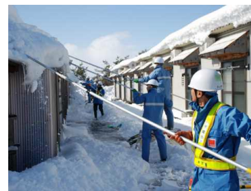
仮設住宅の除雪
