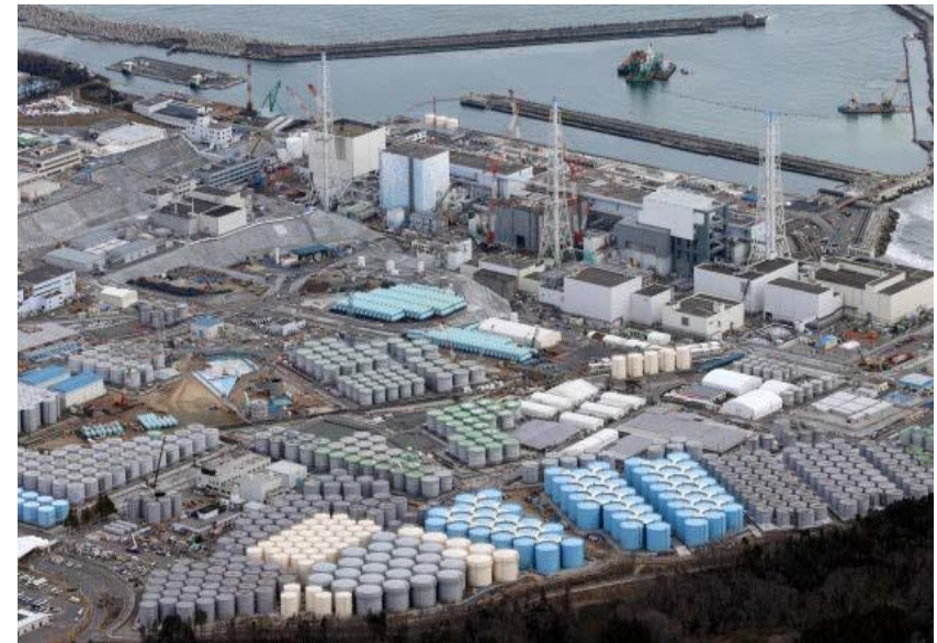
タンクエリアの状況
