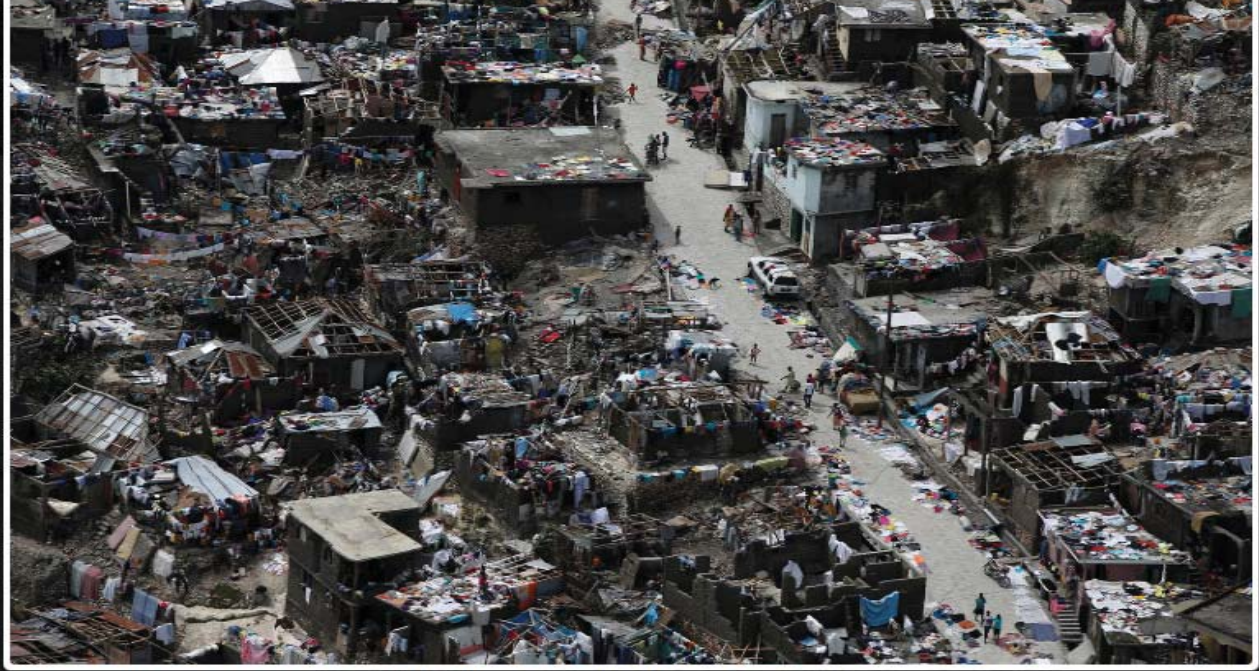
ハリケーンの被害を受け大きく崩れた住宅群=ハイチ西部の自ジェレミーで6日、ロイター
