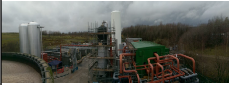
液化空気の貯蔵実証プラント(Manchester, UK)
