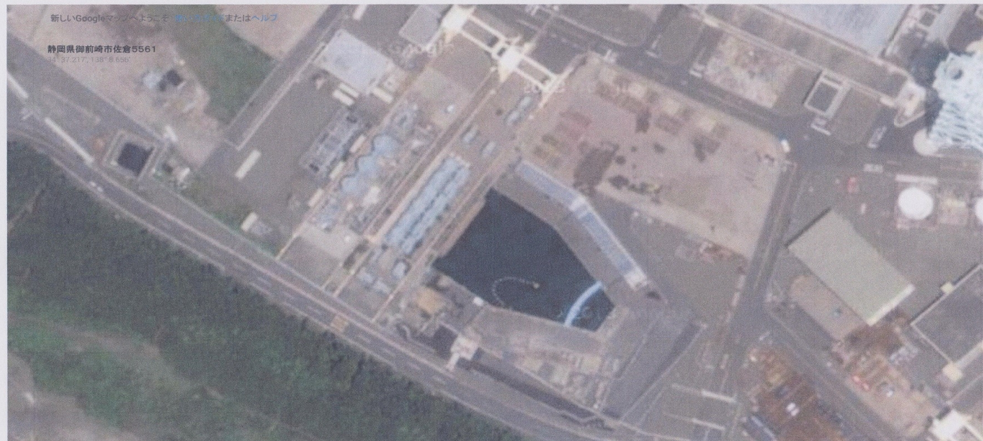
(図一2) 浜岡原子力発電所3号機インテーク写真 非常用機器冷却水ポンプが鮮明に見える
